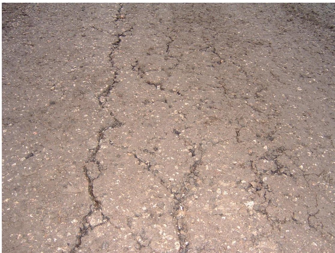
Foto n. 6 – Particolare della sommità arginale da cui si evidenzia il degrado del manto d'asfalto.
